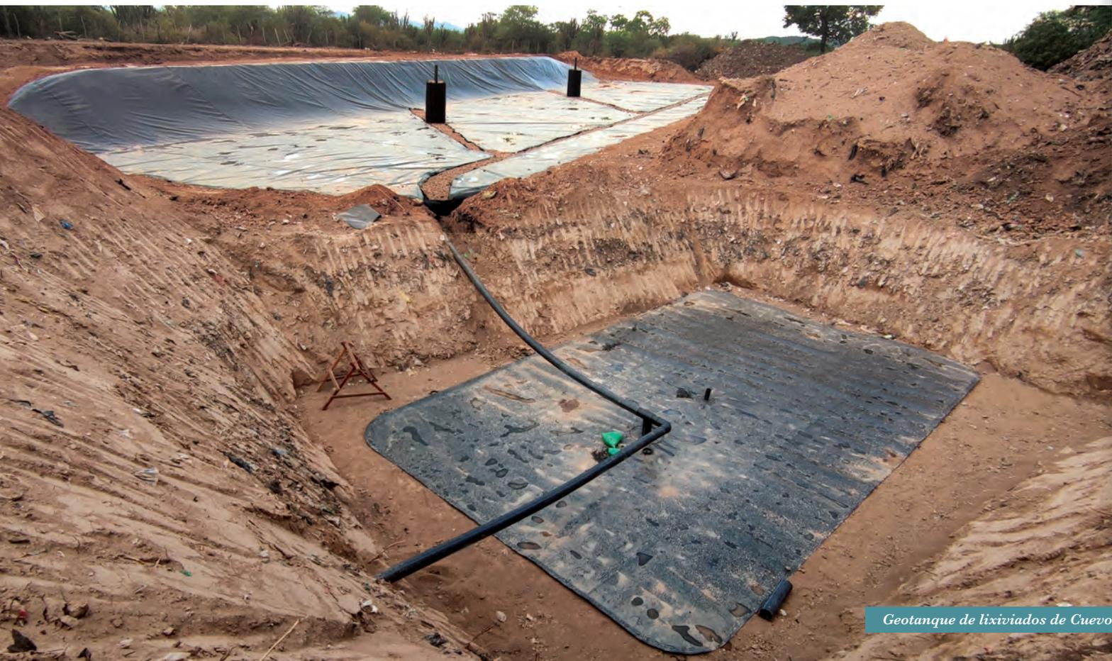
Respecto al biogás, se implementaron captadores pasivos (Figura 20) tanto en la celda de cierre como en la celda de operación del relleno sanitario para centralizar el flujo de gases que se generan por la descomposición de los residuos.
